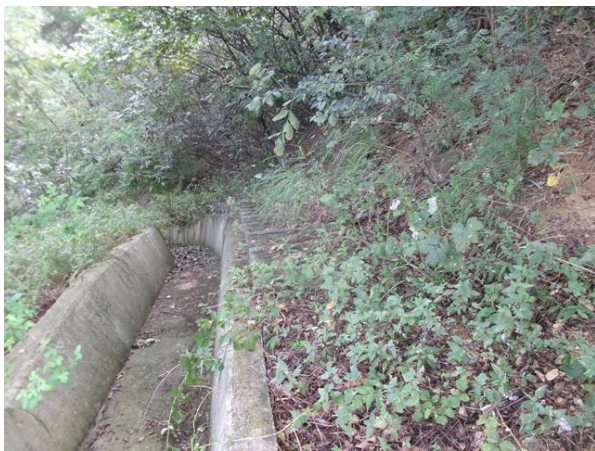
점검계단 및 산마루측구 전경
