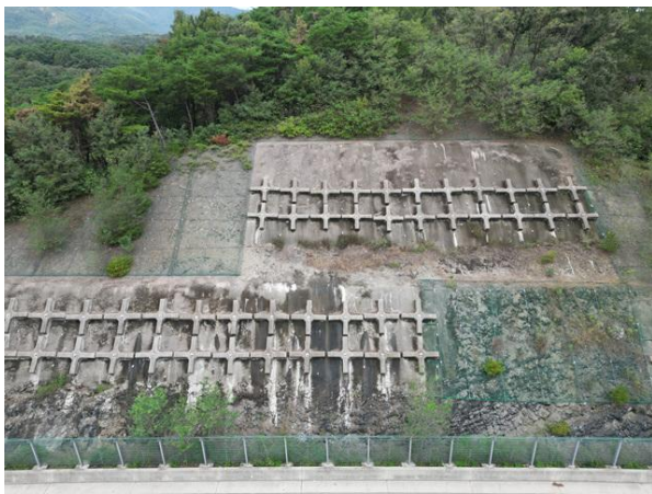
숏크리트, 격자블럭 전경
