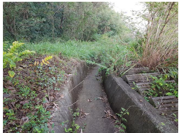
점검계단, 산마루측구 전경
