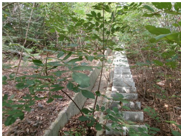
산마루측구, 점검계단 전경
