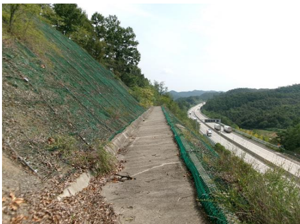
1소단 배수로 전경
