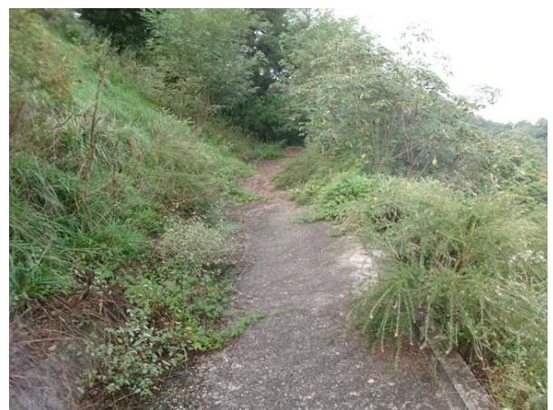
1소단 배수로 전경
