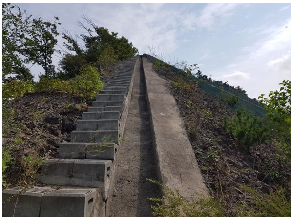
산마루측구, 점검계단 전경
